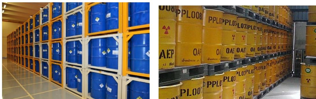
Slika 10. Načini slaganja kontejnera sa radioaktivnim otpadom u skladištu.<sup>22</sup>
